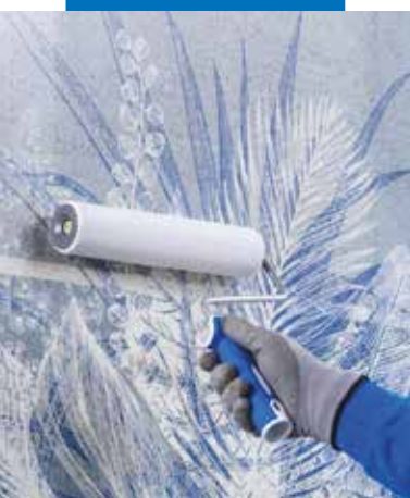
Stesura di Mapecoat Decor Protection su fibra di vetro decorativa
