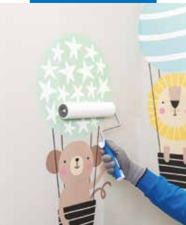
Stesura di Mapecoat Decor Protection su carta da parati stampata
